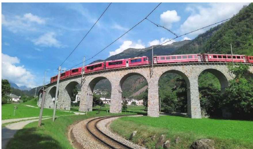
Das bahntechnisch einmalige Kreisviadukt in Brusio.
